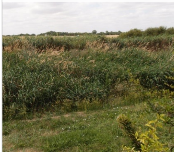
Ci contre : STEP à Dadonville (Denainvilliers) (source : ADEV Environnement)
