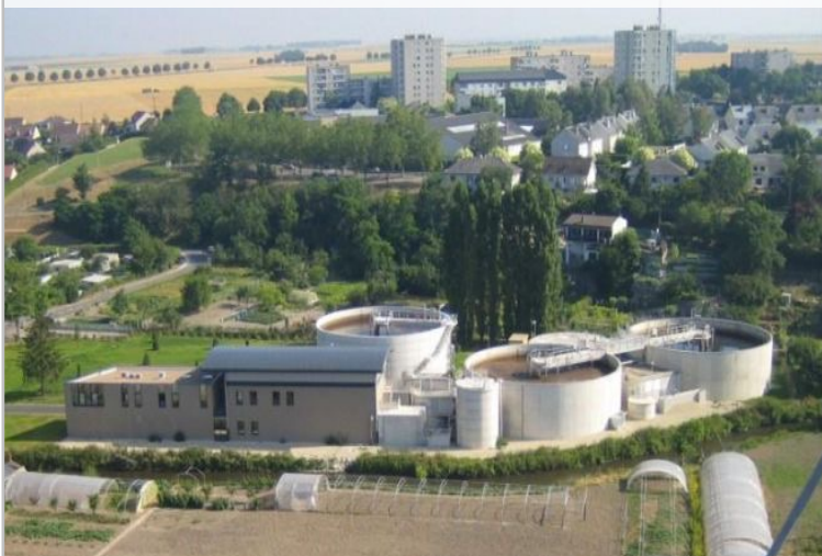
Station d'épuration de Pithiviers – Gué aux Dames (source : Ville de Pithiviers)
