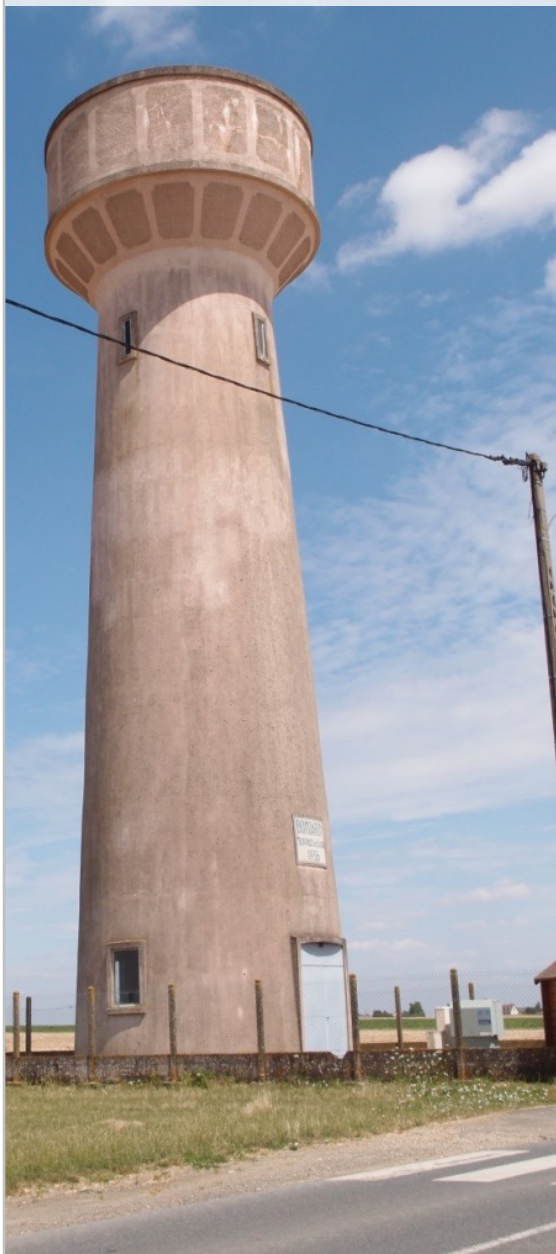
Château d'eau de Bondaroy (source : ADEV Environnement)
